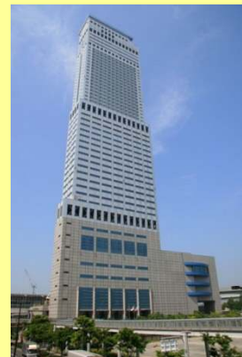
りんくうゲートタワービル外観
