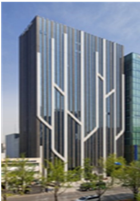
名称：ドーミーイン プレミアム ソウル カロスギル駐車場 住所：ソウル特別市江南区島山大路119 設備：機械式 タワー駐車場 2基 運営：2015年9月より
