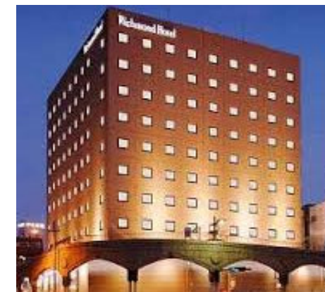
リッチモンドホテル鹿児島金生町（鹿児島） 時間貸しマネジメント物件 運営台数：36台
