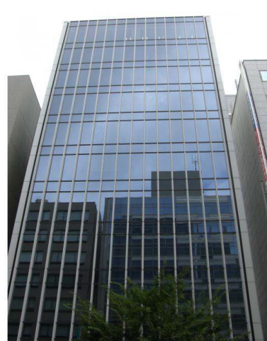
金沢上堤町ビル
