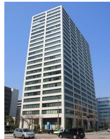
名古屋東京海上日動ビル
